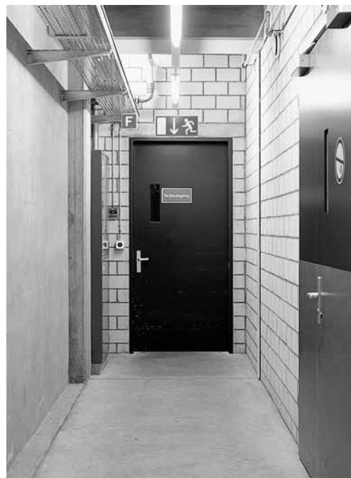
Bild 3: Fluchtweg mit Türe, die sich in Richtung des Fluchtweges öffnen lässt.
