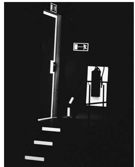
Bild 5: Beispiel einer Kennzeichnung mit Leuchtbandern (Situation bei Dunkelheit).
