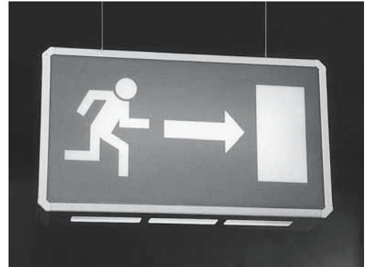
Bild 1: Tafel zur Kennzeichnung des Rettungswegs.
