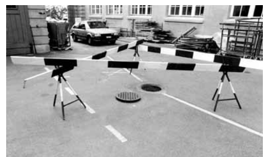
Bild 9: Temporär abgeschränkte Reparaturstelle.
