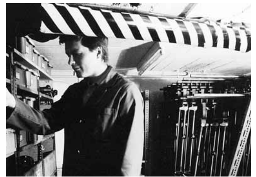
Bild 5: Ablaufrohr neben Lagergestell, mit gelb-schwarz markiertem Schaumgummi gepolstert.
